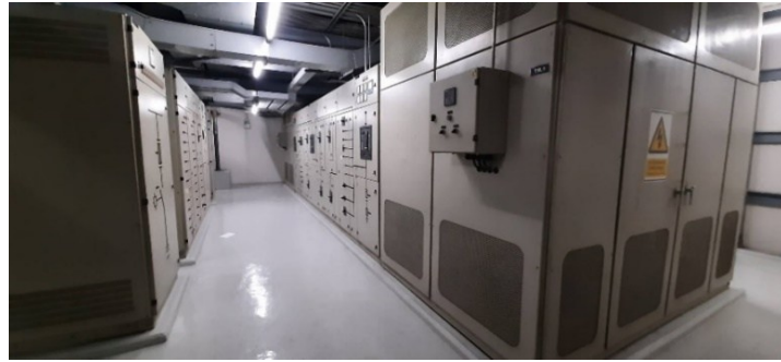
ภาพที่ 5-16 ห้องหม้อแปลงไฟฟ้า
